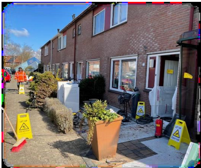
Werkzaamheden leidingrenovatie wijk
